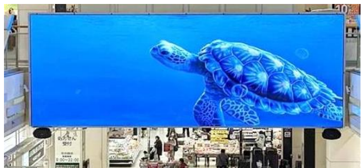
正面入口に212インチのサインージ設置
